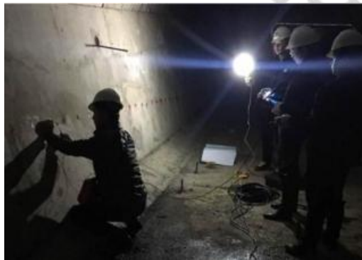
现场检测情景
