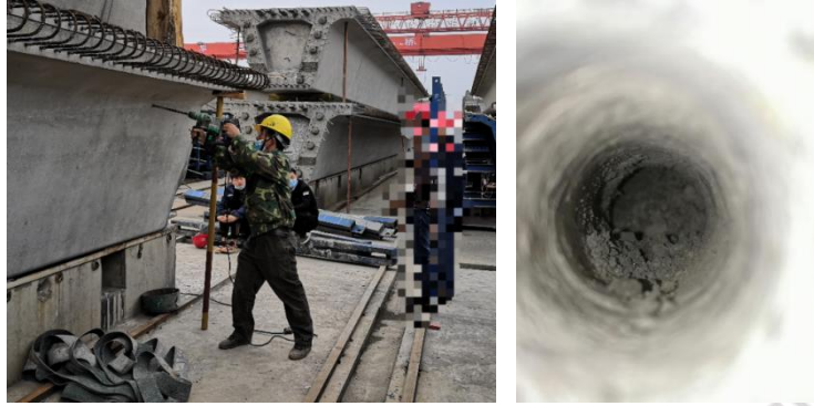
现场打孔场景及孔内情况
