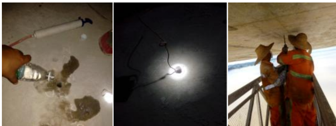
现场注水、穿铁丝及钻孔情景
