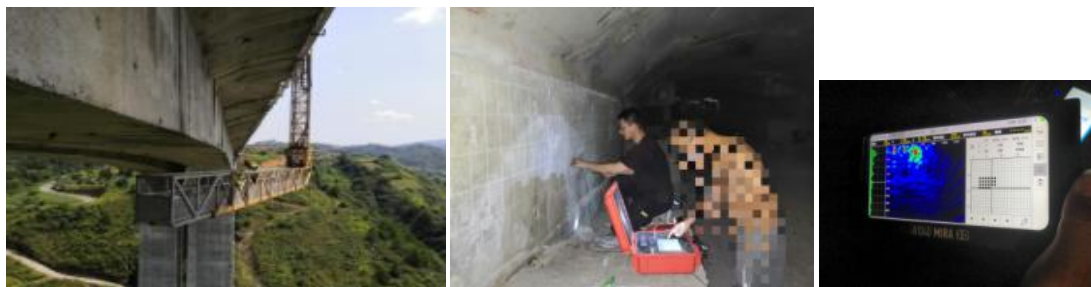
图 3-3-7 大桥检测相关照片
