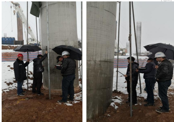
图 4-3-12 混凝土强度现场检测
