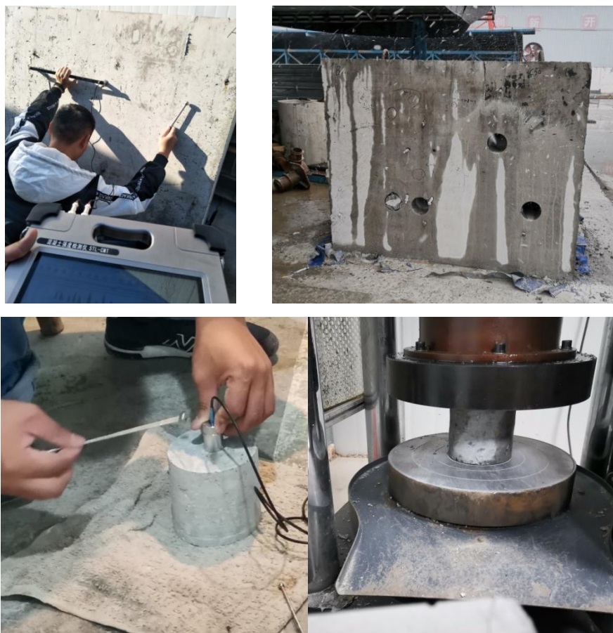
图 4-3-14 强度模型测试、取芯、芯样测试、芯样压载
