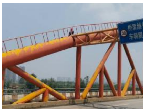
图 2-4-1 现场检测照片
