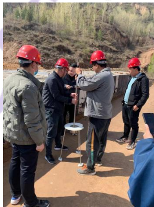
图 2-7-35 现场检测场景
