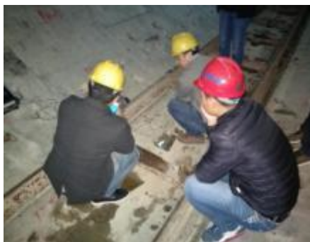
现场检测场景
