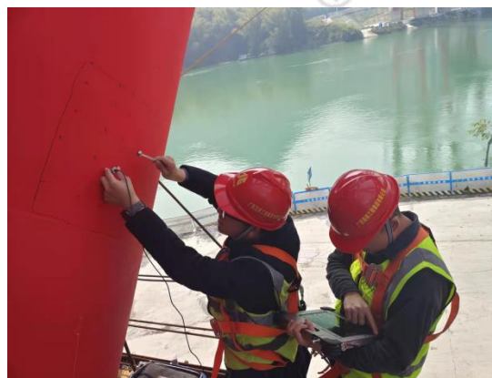
右：钢管混凝土内部质量检测
