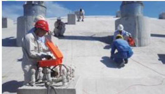
现场检测场景
