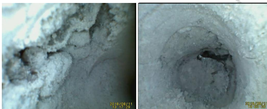
某隧道右拱腰 888
