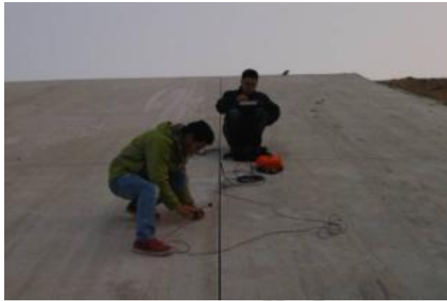
脱空现场测试场景
