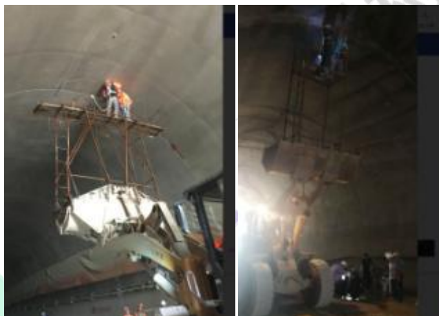
雷达和弹性波检测情景
