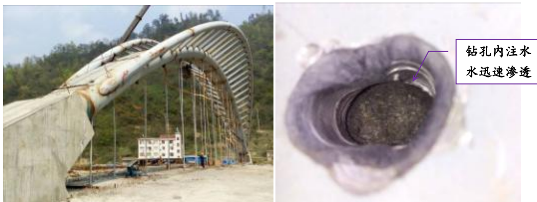
钢管桥外观及钻孔验证情景
