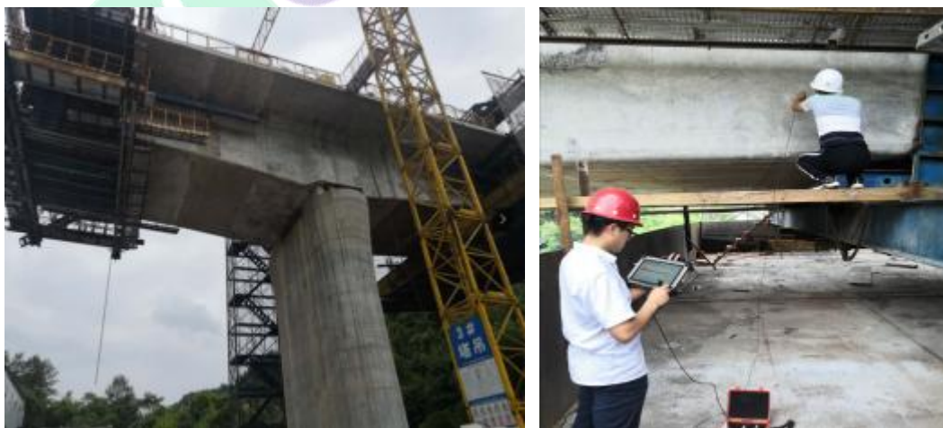
SF-HR 大桥及左侧腹板现场检测图
