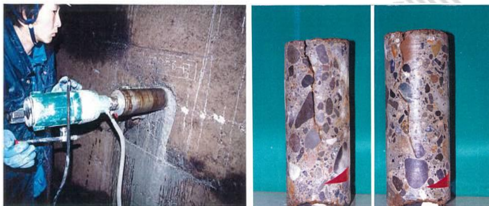
照片 2-4-5 钻孔验证场景 照片 2-4-6 钻孔结果
