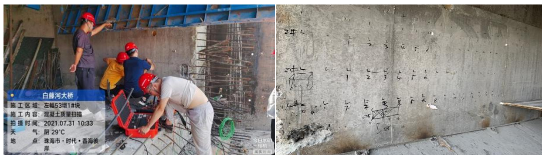
现场检测场景照片
