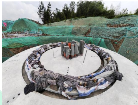
现场结构实图
