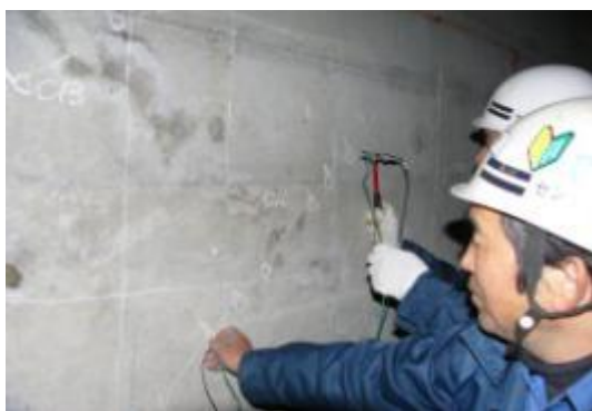
照片 2-4-3 现场测试场景
