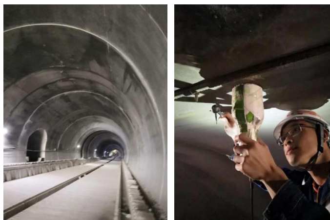
现场测试情景
