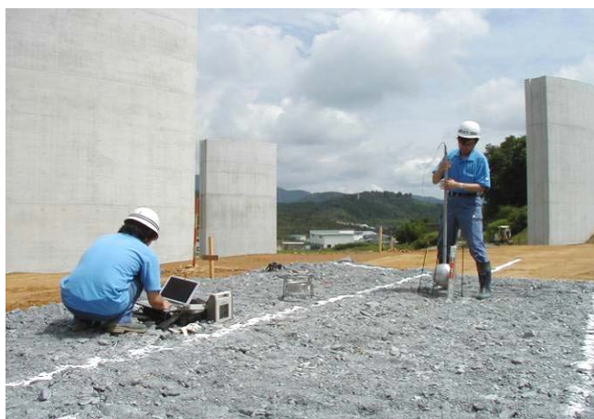
现场验证（日本、某机场工程，载荷板试验）
