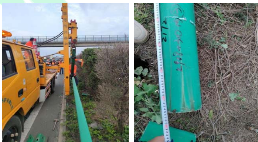
现场验证图（左：现场拔桩 右：实际量测）
