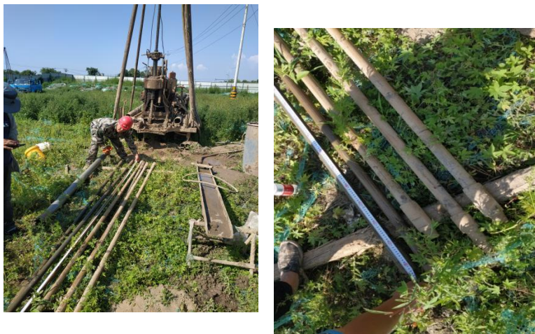
图 2-8-12 现场检测场景
