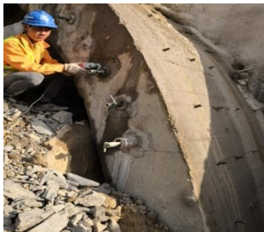
管棚长度质量现场检测图
