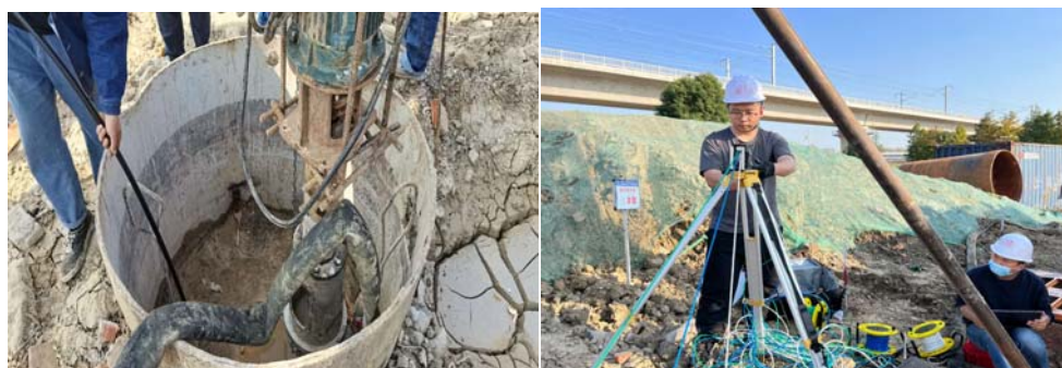
被检对象及现场检测场景
