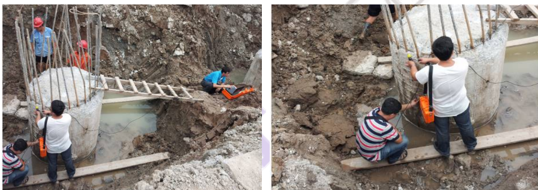
现场检测场景
