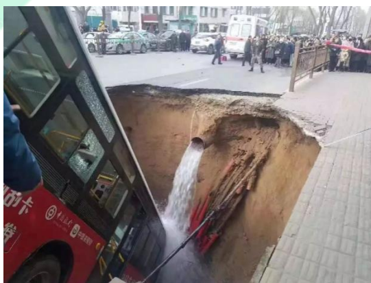
某城市道路道路坍塌
